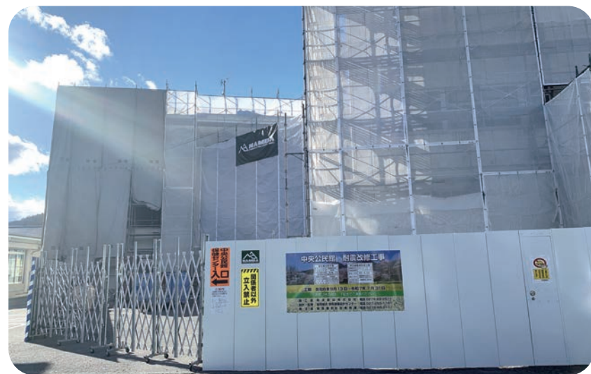
耐震改修工事中の中央公民館
