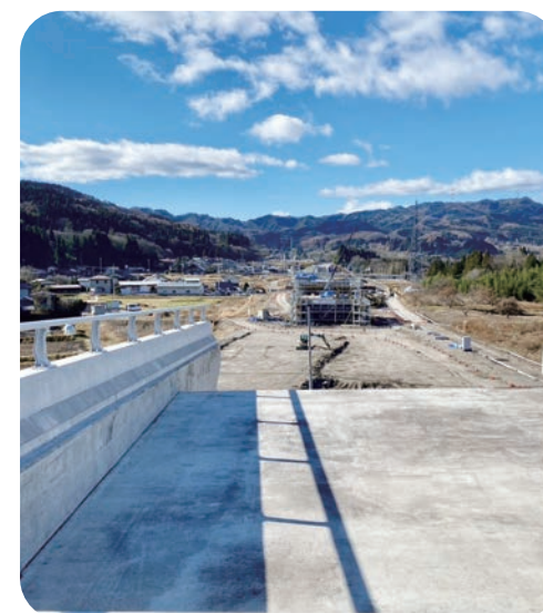
建設中の上信自動車道（厚田）
