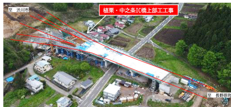
植栗中之条インター 付近の工事状況
